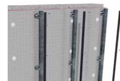
드레인 스트랩 설치
