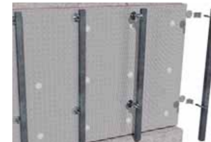
각관 하지 공사
