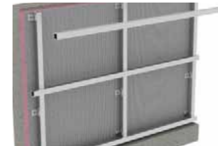
각관 하지 공사
