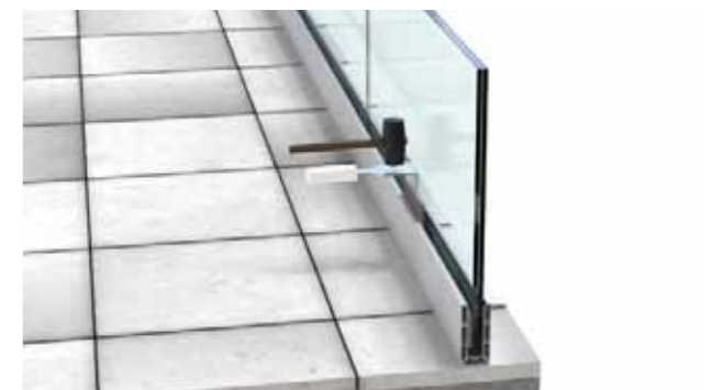
6. 내부 방향에 웨지를 삽입한 후, 모든 웨지가 제 위치에 있으면 웨지 삽입기와 망치를 사용하여 유리가 잠길 때까지 삽입합니다.
